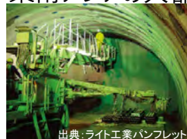
補助工法の施工
