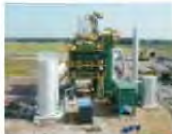
インドネシア マジャレンカ市に建設されたリサイクルアスファルトプラント。
