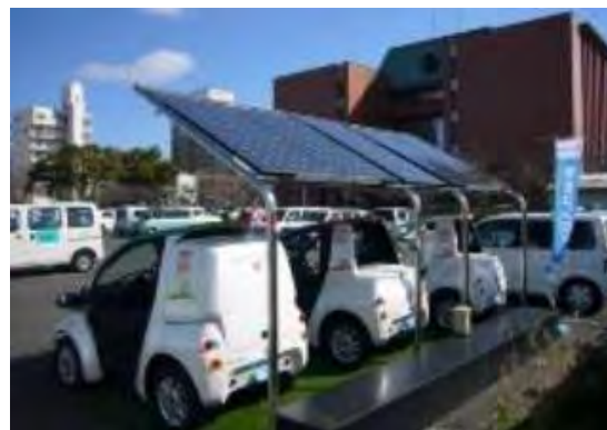
太陽光蓄電システム
