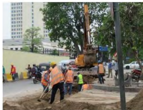
雨水管の工事現場
