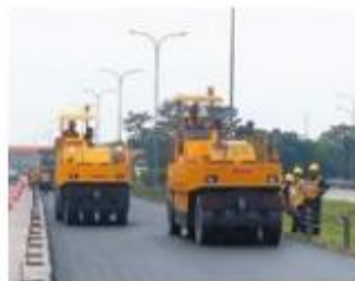
インドネシアでのリサイクルアスファルトの施工状況。
